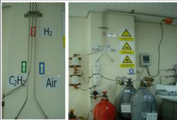
가스의 종류 및 흐름방향 표시 적정
